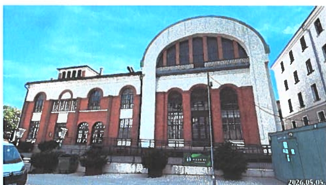
(udvari) DNY-i homlokzat a főbejárattal
