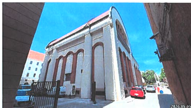
DK-i homlokzat a Gerlóczy IV. sz. kapu felől
