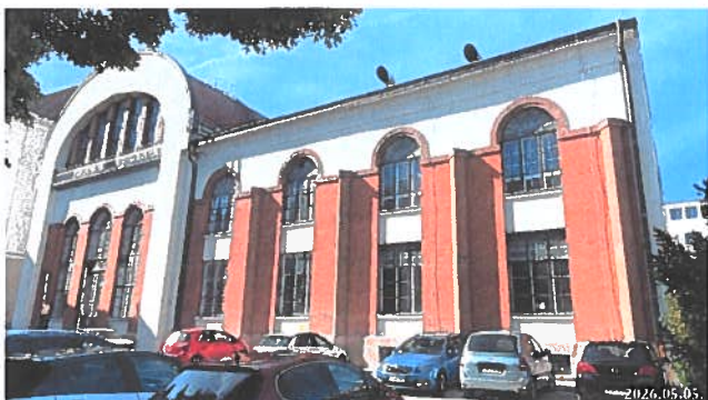
Károly körút felőli ÉK-i homlokzat
