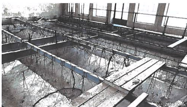
Acélváz szerkezetre függesztett beton földem
