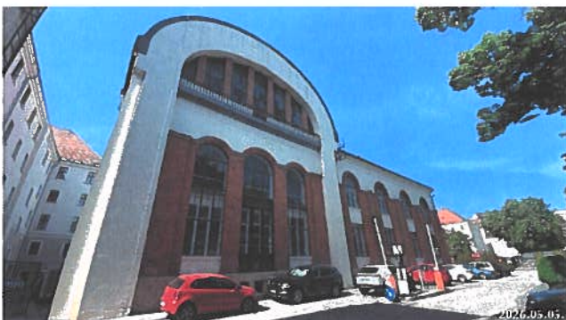
Károly körút felőli ÉK-i homlokzat
