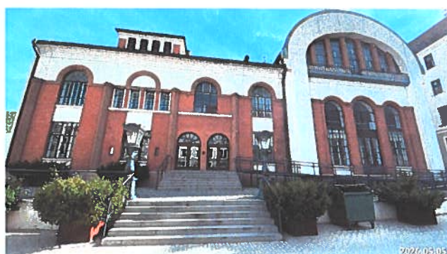
(udvari) DNY-i homlokzat a főbejárattal
