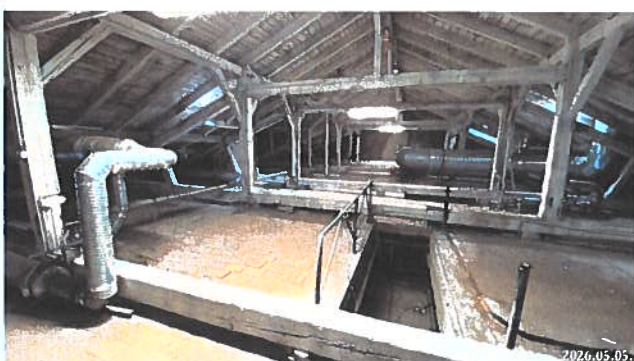
Bakdúcokkal gyámolított 3 állószeles fedélszék
