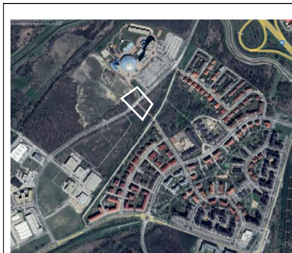
Légi felvétel a területről 2013-ban (forrás: Google Earth, módosítási javaslattal érintett ingatlan fehér kontúrral jelölve)
