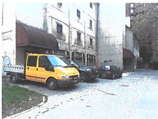
Az épület bejáratai (északi oldal)
