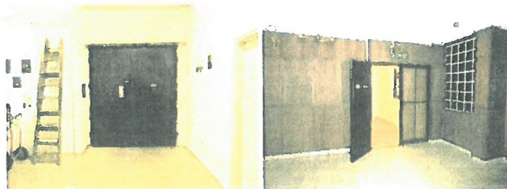
A teherlift, illetve a lépcsőház
