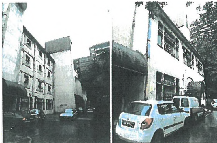
Az épület főbejárata (északi oldal)
